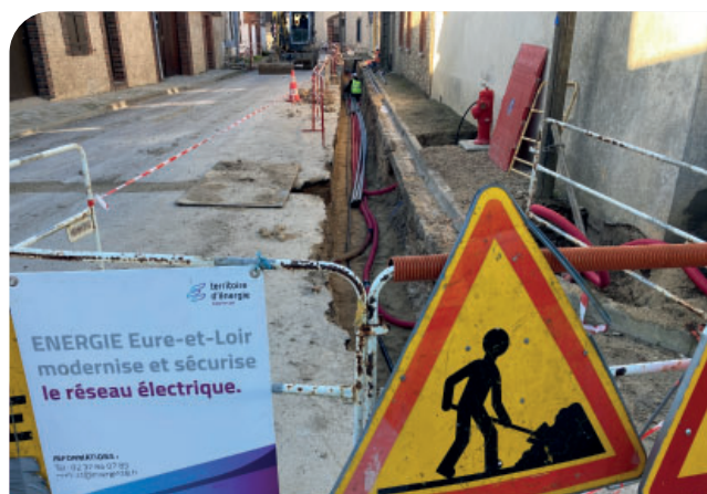
Lors des enfouissements des réseaux aériens, ENERGIE Eure-et-Loir coordonne l'ensemble des intervenants sur le chantier.
