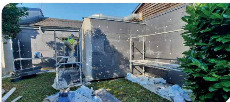
Isolation par l'extérieur de l'école de Hanches
